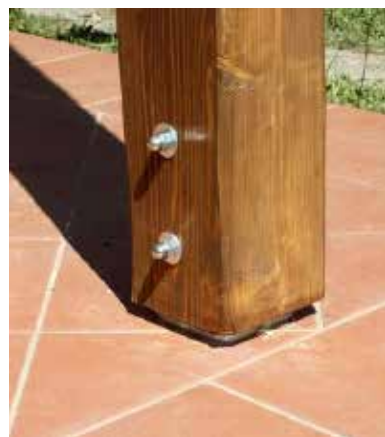
Portapilastrò T104 ventilato installato.
