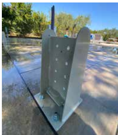
Portapilastro TL110 ventilato installato.
