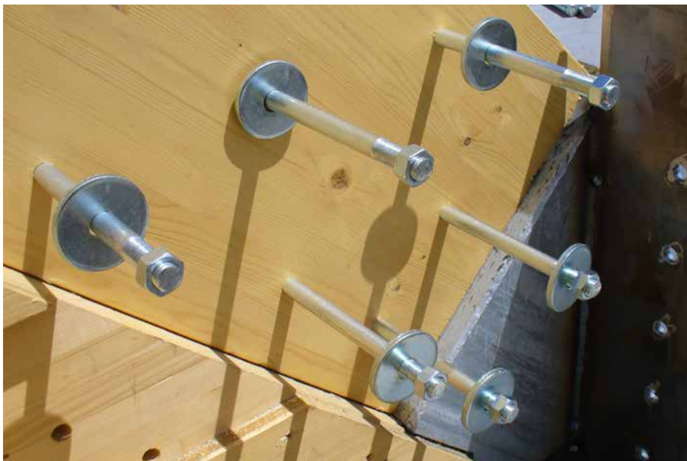
Inserimento di bulloni per una connessione trave-lama in acciaio a scomparsa.
