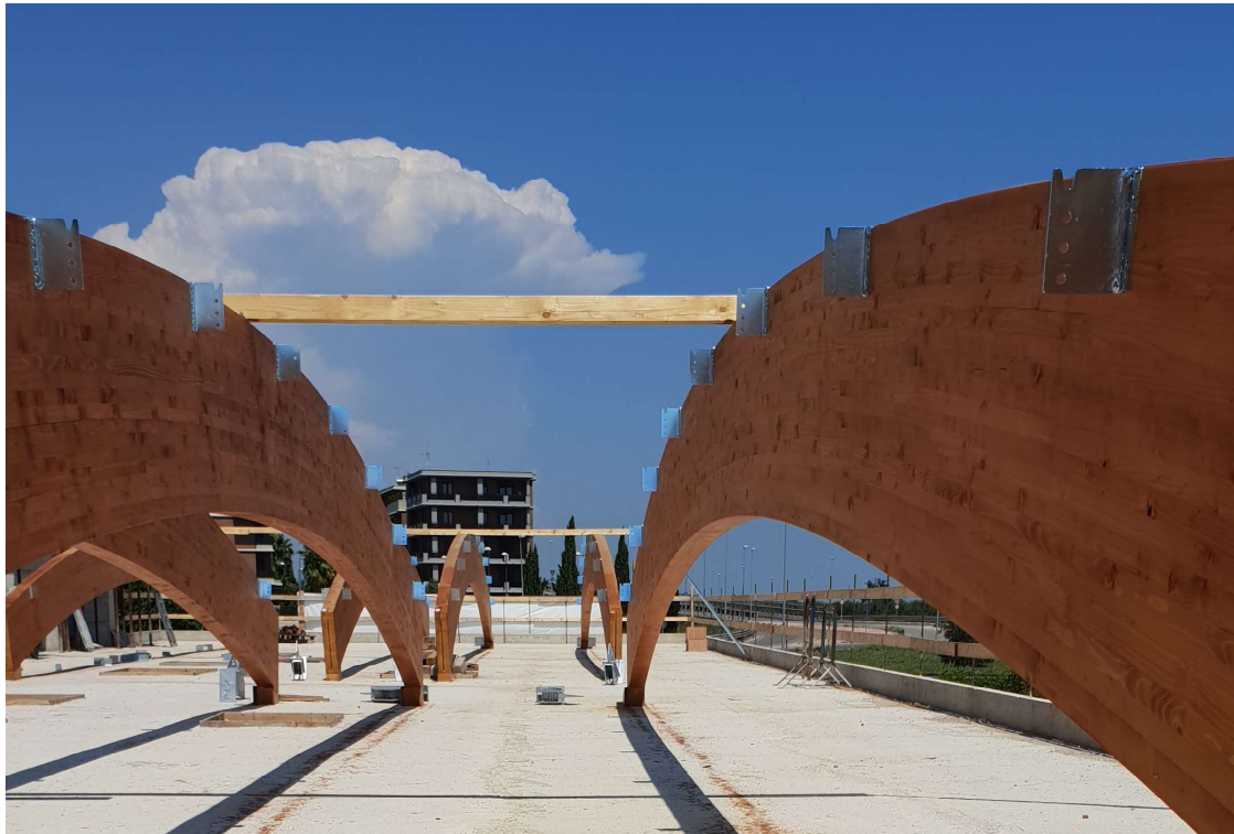
Installazione piastre Steel su trave curvo
