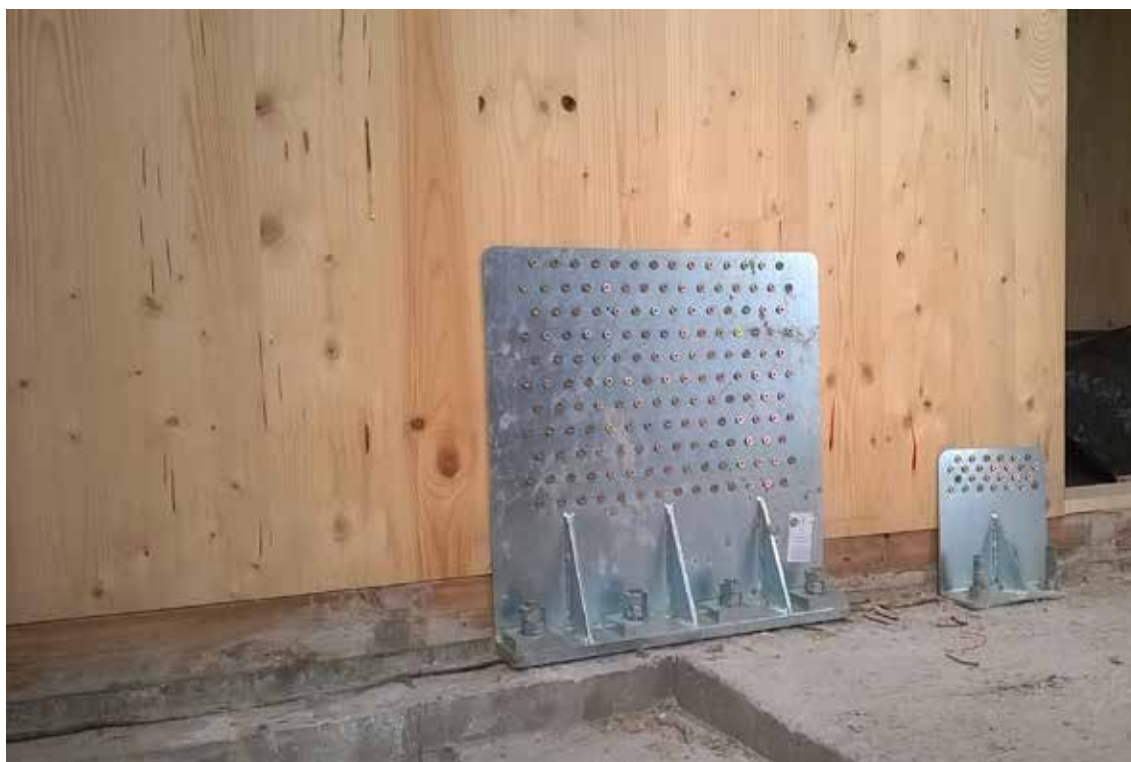
Angolari speciali, realizzati su misura, per sforzi di trazione e taglio su un edificio multipiano.
