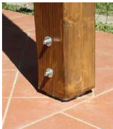
Portapilastro T104 ventilato installato.
