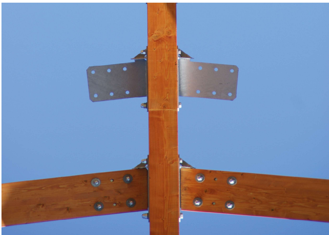
Connessione schiena-schiava di piastre a scomparsa tramite bulloni
