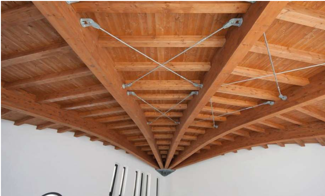
Tiranti per il controventamento della copertura in legno
