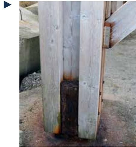
Un collegamento realizzato in modo tale da non permettere il ristagno dell'acqua e la cui ferramenta è protetta dalle intemperie: si presenta così.
