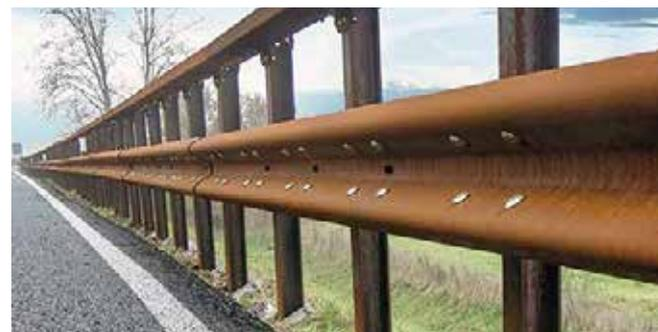
La caratteristica principale dell' acciaio tipo COR-TEN è quella di auto proteggersi dalla corrosione elettrochimica, mediante la formazione di una patina superficiale compatta passivante, costituita dagli ossidi dei suoi elementi di lega, tale da impedire il progressivo estendersi della corrosione; tale film varia di tonalità col passare del tempo, solitamente ha una colorazione bruna.
