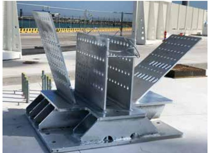
Connessione metallica di base per una struttura in legno. I rinforzi interni sono stati progettati e saldati secondo una gerarchia per ottenere il massimo risultato statico in fase sismica.
