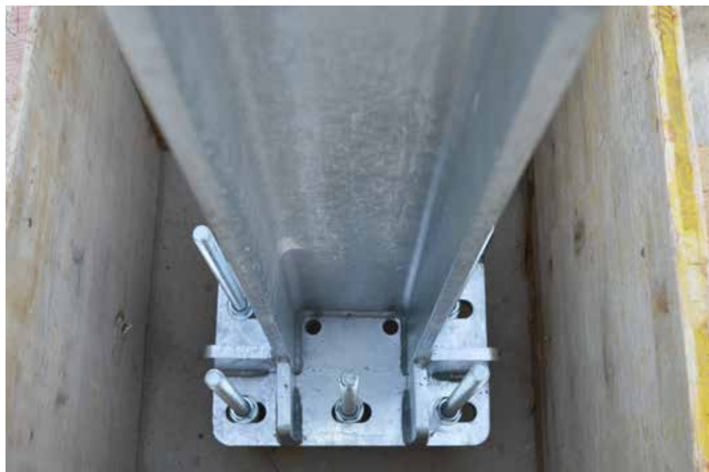
Barra filettata con ancorante chimico
