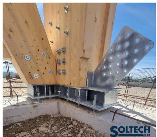
Fig. 6 - Esempio di connessione metallica a progetto
